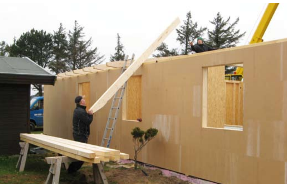
Der Dachstuhl wird abgezimmert
